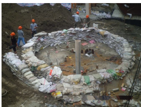
图 5 注浆处理后现场情况
